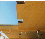
Die Stege aus flexiblen Plattenmaterial wie Sperrholz oder OSB bilden ein robustes inneres Fachwerk.
