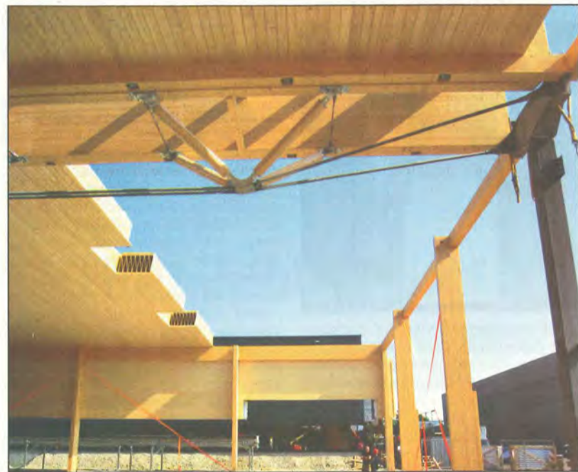
Die 10,50 m hohe, nahezu vollständig hölzerne Hallenkonstruktion ist – abgesehen von einer Mittelreihe mit drei Innenstützen – auf ihrer Gesamtgröße von 66 x 46 m freitragend. Dank der wenigen Stützen ist man in der Produktion später räumlich sehr flexibel
