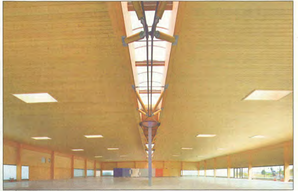
Die Beheizung und Klimatisierung der Halle erfolgt durch thermische Bauteilaktivierung der Bodenplatte. Die Beheizung der Lackieranlage, des Lackraumes und des Trockenraumes erfolgt mittels Flüssiggas Fotos: Baierl & Demmelhuber
