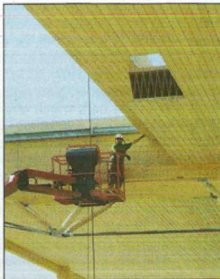
Kielsteg-Elemente: Schlanke Stege aus flexiblem Plattenmaterial bilden ein robustes inneres Fachwerk
