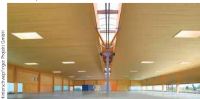
Die nahezu vollständig hölzerne Hallenkonstruktion kommt mit nur drei Stützenreihen aus und ist ansonsten auf einer Gesamtgröße von 66 m x 46 m freitragend.
