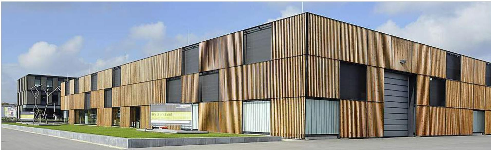
Die nahezu vollständig hölzerne Hallenkonstruktion des Innenausbauers Baierl + Demmelhuber (B+D) kommt mit nur drei Innenstützen aus und ist ansonsten auf einer Gesamtgröße von 66 x 46 Meter freitragend. Das Konzept wurde nun ausgezeichnet.
