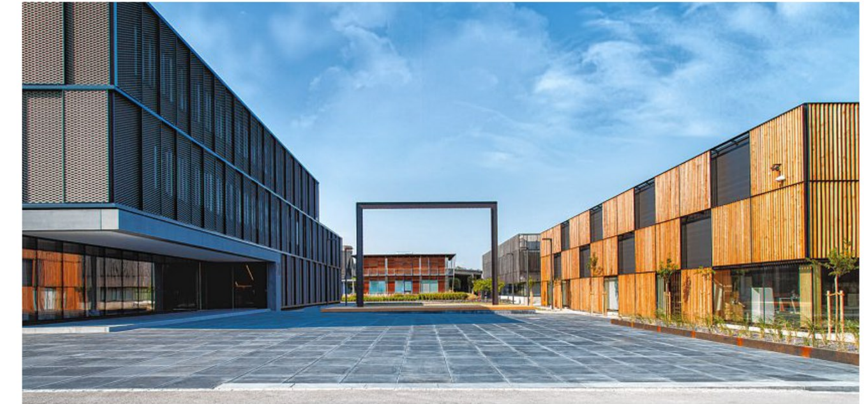
Mit seiner neuen Holzmanufaktur (rechts) und dem Büro-Campus stellt Baierl + Demmelhuber (links) die Weichen für die Zukunft.
