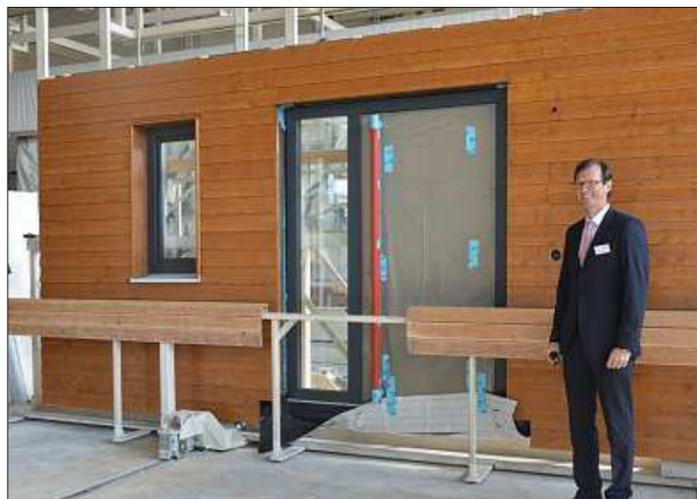
**Michael Regnauer** zeigt eine in den Hallen in Seebruck vorgefertigte Hauswand mit Holzverschalung. Auch verputzte Wände werden unter Dach vorgefertigt und garantieren auf Baustellen kürzestmögliche Montage- und Verarbeitungszeiten.
